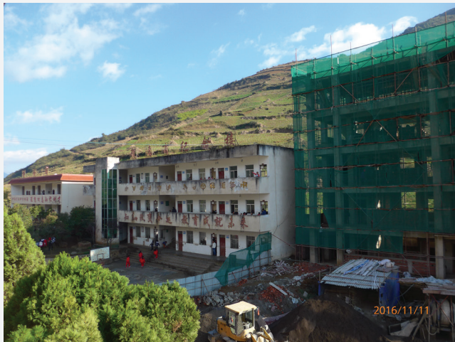
舊的教學樓和正在興建的新教學樓。
